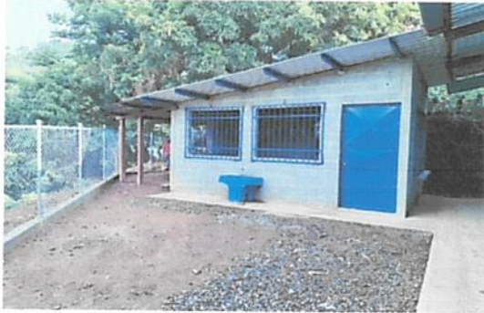
Foto 1: Finalización construcción de cocina.
