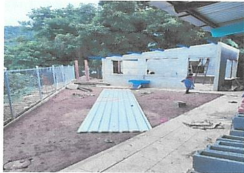
Foto 3: Finalización levantado de paredes.
