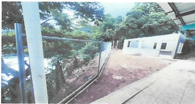
Foto 5: Finalización muro de maya.
